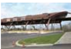
Casello autostradale, Lucca Ettore Piras Architetto, Genova Trenkwald S.r.l., Ovada (AL) TECU® Oxid
