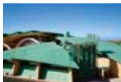
Chiesa di pellegrinaggio «Padre Pio», San Giovanni Rotondo (FG) Renzo Piano Building Workshop, Genova WAL S.r.l., Bregnano (CO) TECU® Patina
