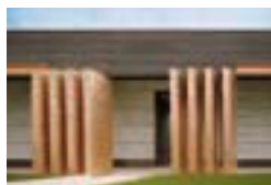
Cimitero Trescore Ing. Augusto Zambelli, Trescore Balneario (BG); Arch. Basilia Barcella, Bergamo EFFEGI Costruzioni S.r.l., Castelli Calepio (BG) TECU® Bronze
